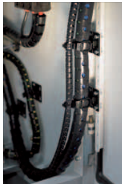
Med Helawrap tilbehørsæt kan kablerne bundtes, beskyttes og fastgøres på el-skabe i industrianlæg
