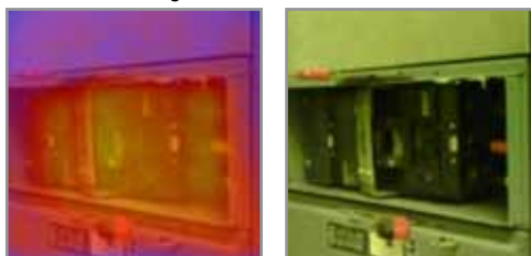
Normální provozní teplota na kritickém jističi
