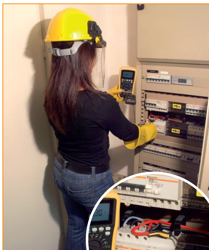
La souplesse des capteurs est appréciable sur les tableaux électriques, industriels ou domestiques.
