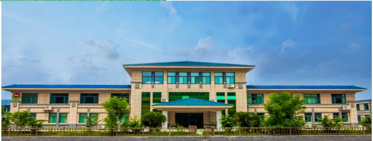
工厂外景图：办公大楼
