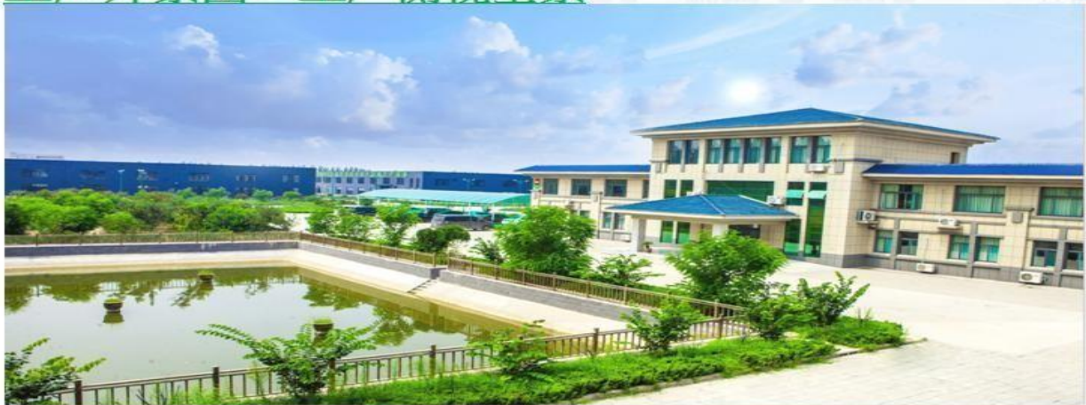
工厂外景图：工厂侧视全景
