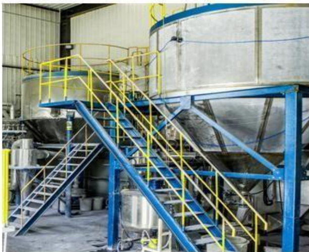
工厂车间场景图：造粒车间
