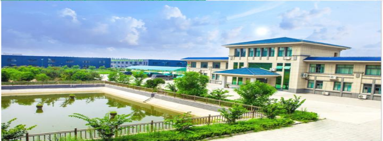
工厂外景图：工厂侧视全景
