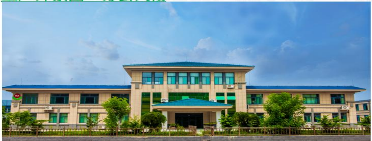
工厂外景图：办公大楼
