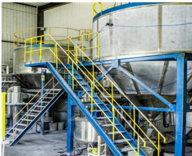
工厂车间场景图：造粒车间
