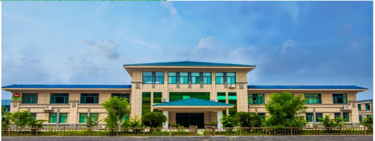
工厂外景图：办公大楼
