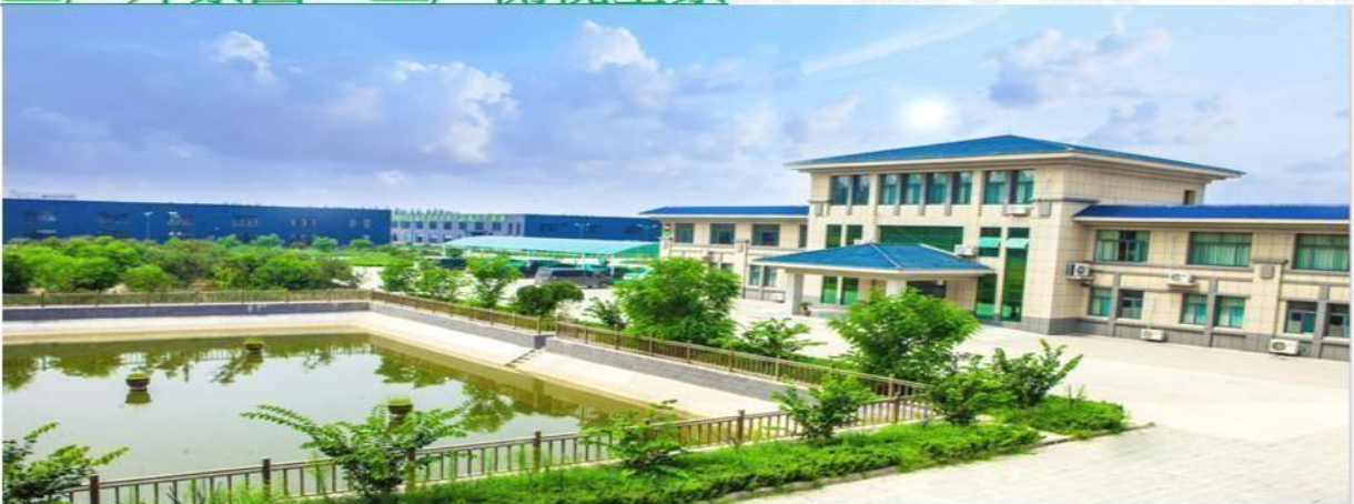
工厂外景图：工厂侧视全景
