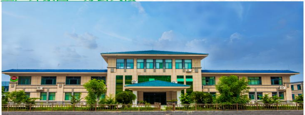
工厂外景图：办公大楼
