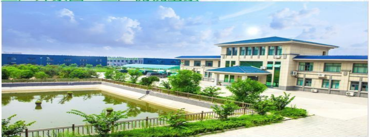
工厂外景图：工厂侧视全景
