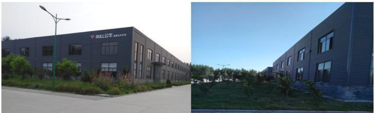
工厂外景图：一号车间
