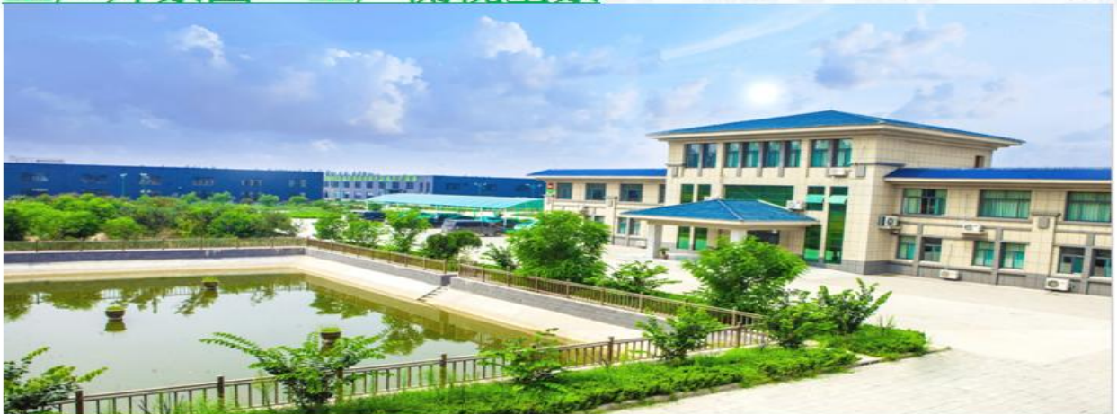
工厂外景图：工厂侧视全景
