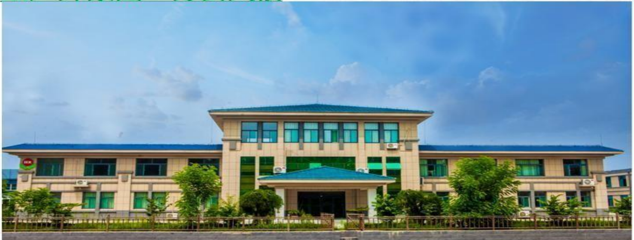
工厂外景图：办公大楼
