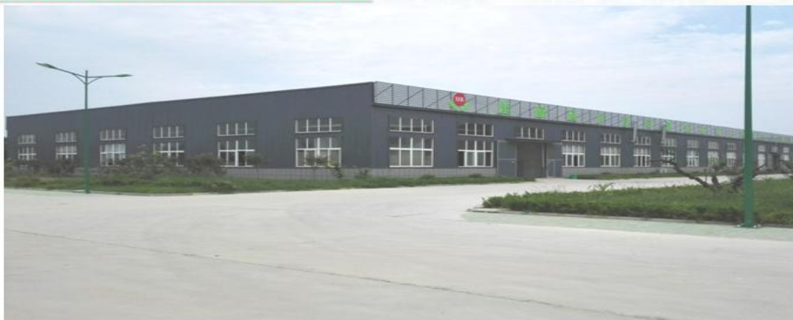
工厂外景图：三号车间
