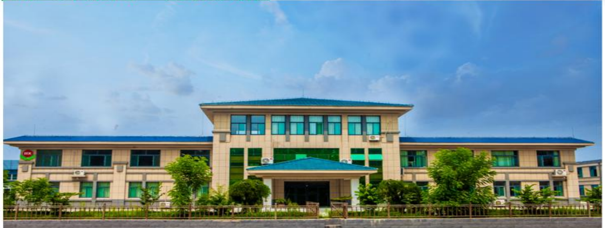
工厂外景图：办公大楼
