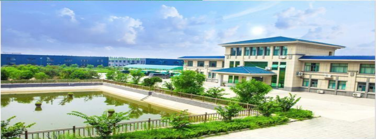
工厂外景图：工厂侧视全景
