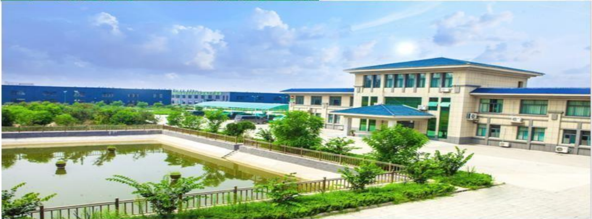
工厂外景图：工厂侧视全景
