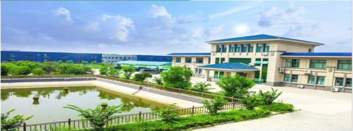
工厂外景图：工厂侧视全景
