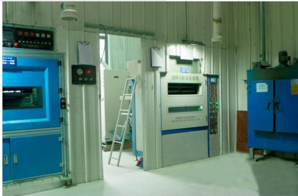
工厂车间图：环氧封装站
