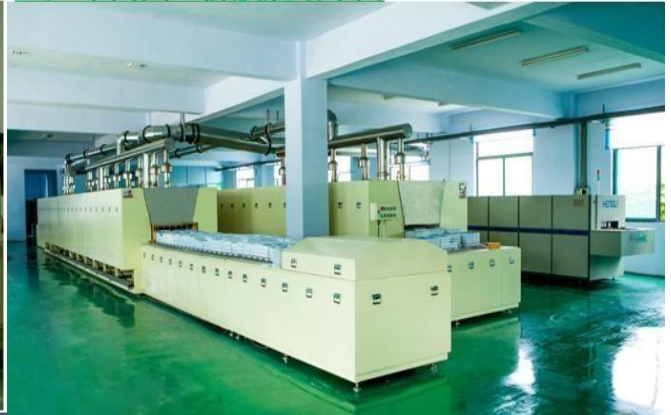
工厂车间图：排胶烧结车间
