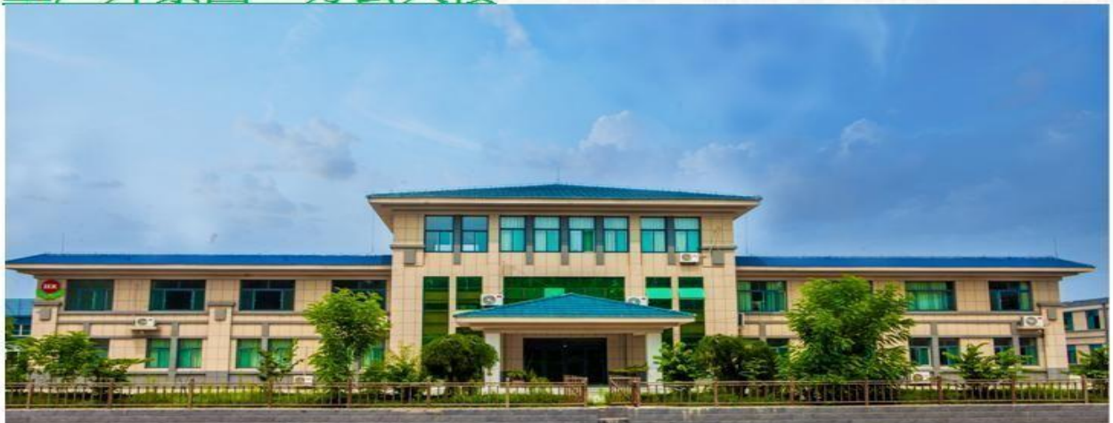
工厂外景图：办公大楼
