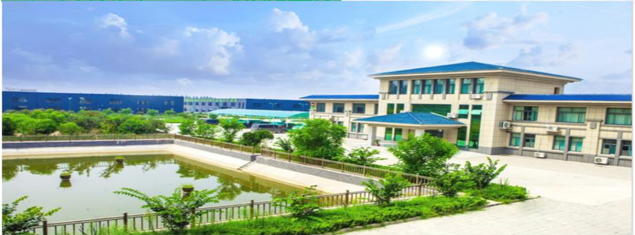
工厂外景图：工厂侧视全景
