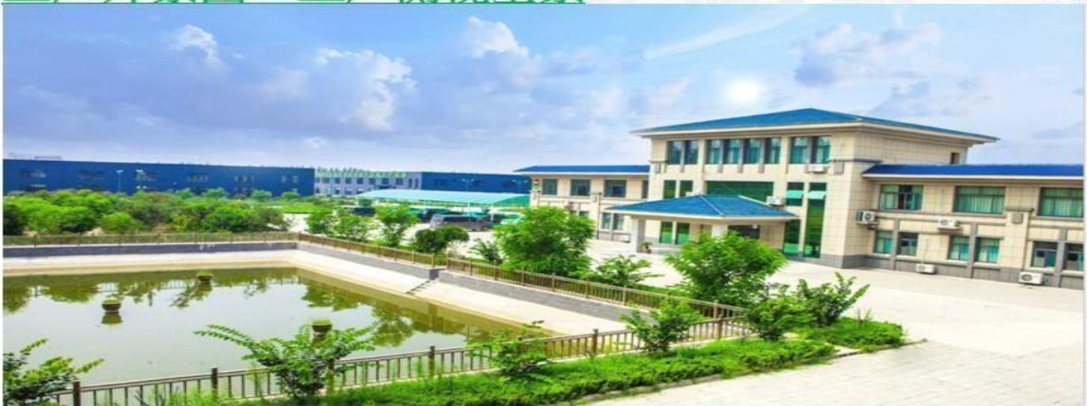
工厂外景图：工厂侧视全景
