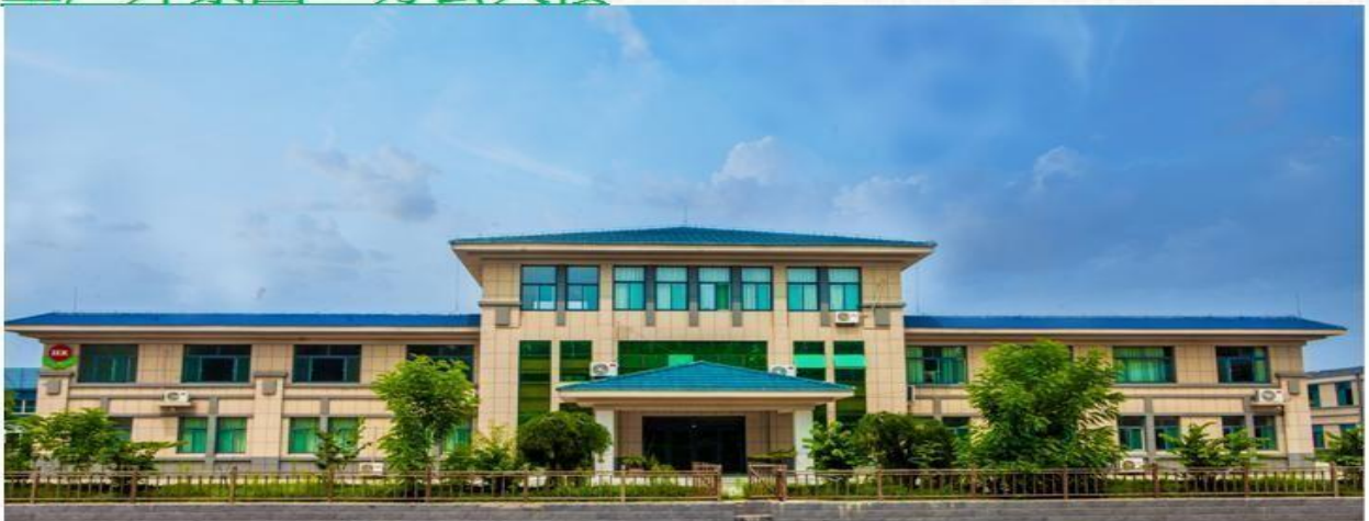
工厂外景图：办公大楼
