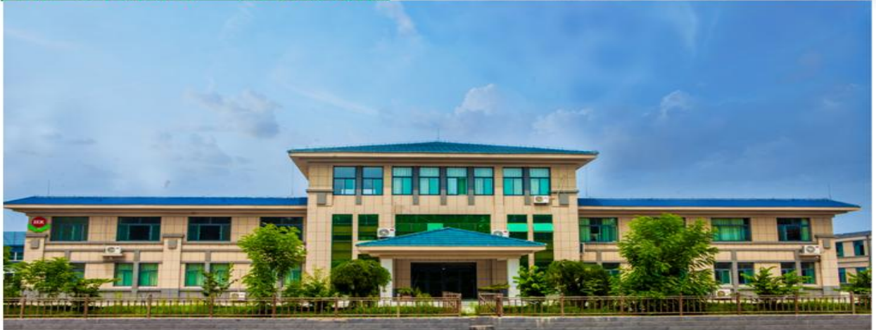
工厂外景图：办公大楼
