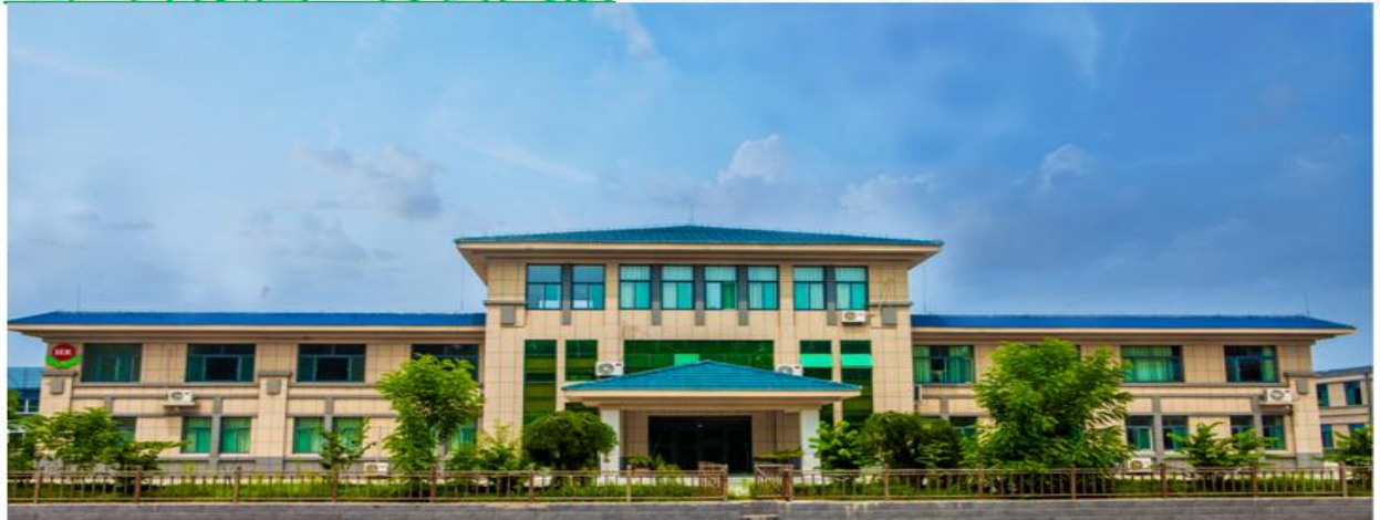
工厂外景图：办公大楼
