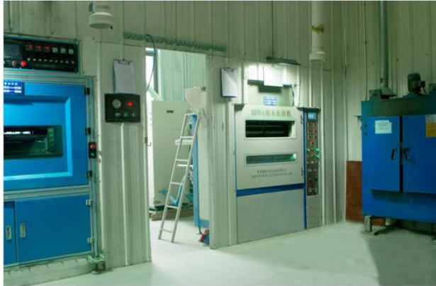
工厂车间图：环氧封装站
