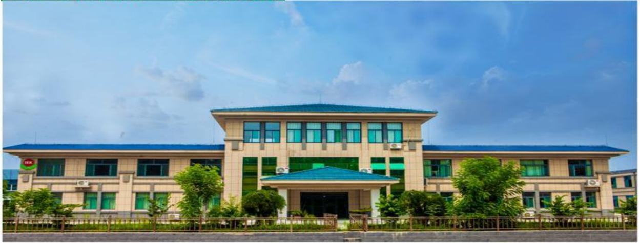
工厂外景图：办公大楼
