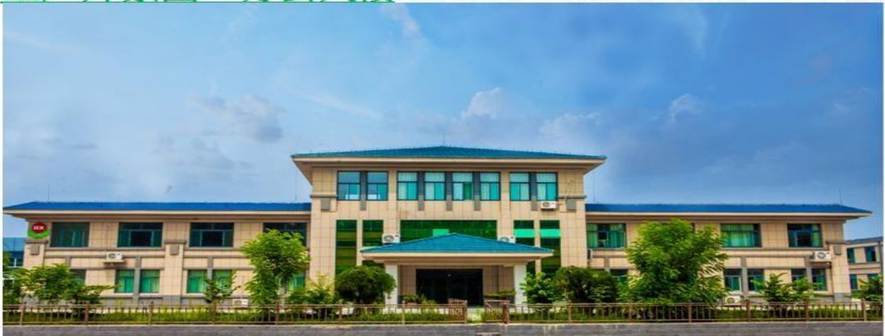
工厂外景图：办公大楼
