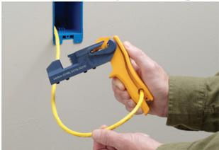
1. Ziehen Sie den Kabelmantel mit einer Standard-Abisolierzange oder der integrierten Abisolierzange ab.
