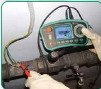
Continuity check of equipotential bonding
