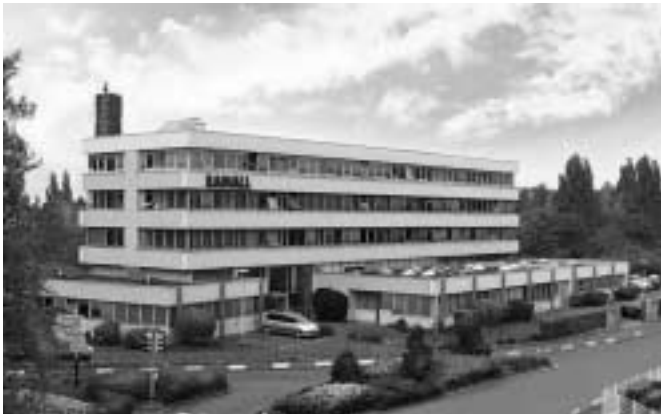
Head Office - Rosny sous Bois
