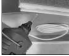
Posa di cavi del telefono.
