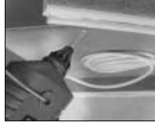
Föräggning av telefonkabel.
