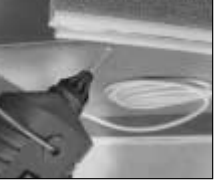
Telefonikaabli paigaldamine.
