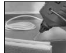
Telefona kabeļu izvietojšanai.
