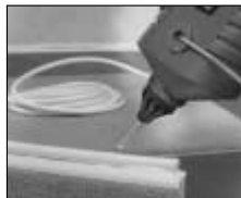
Прокладка телефонного кабеля
