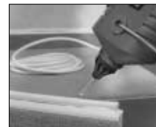
Poser des câbles téléphoniques.
