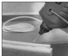
Förläggning av telefonkabel.
