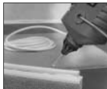
Montarea cablurilor telefonice
