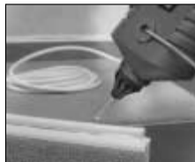
Εγκατάσταση καλωδίων τηλεφώνου.
