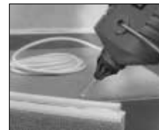
Lepení telef. kabelů.
