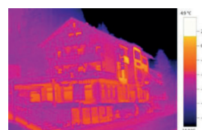
Wärmebild mit testo ScaleAssist
